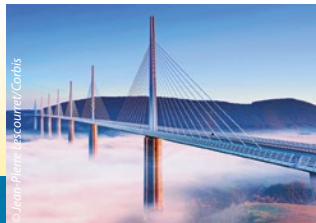
Le viaduc de Millau (France), l'un des ponts les plus élevés au monde.
