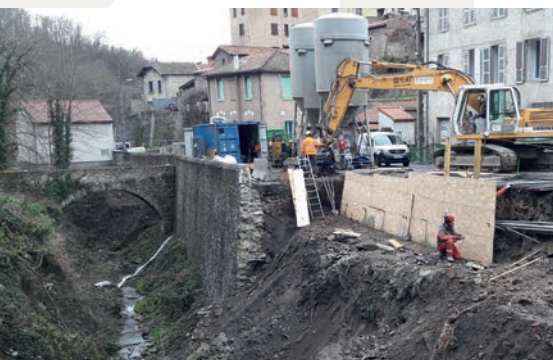
A Auzon, le Fonds 199 a permis de financer la reconstruction d'un mur écroulé le long de la route
